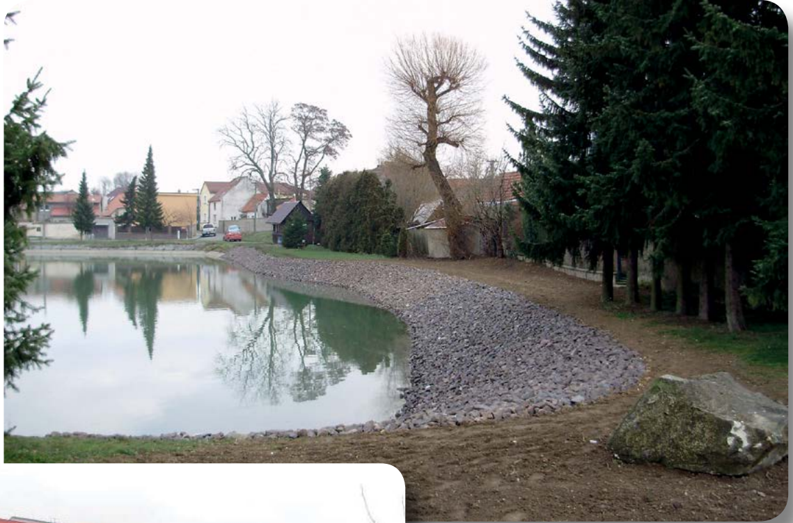
Rekonstrukce Panského rybníku včetně zpevnění břehů v obci Jeneč
