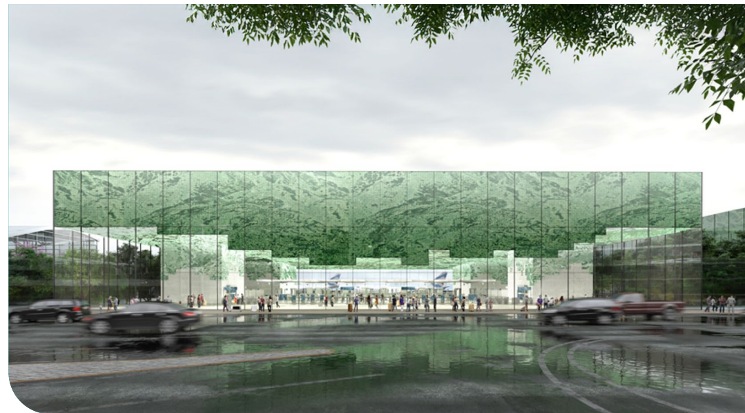
Přístavba Terminálu 1 - objekt centrální bezpečnostní kontroly
