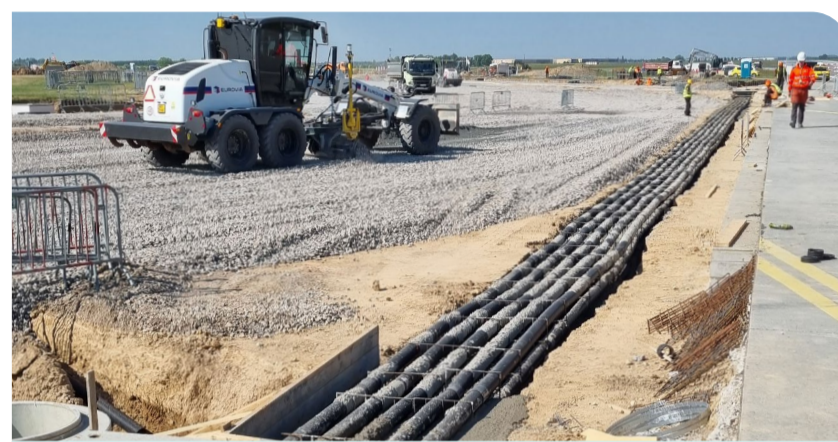
Výstavba nového kabelovodu
